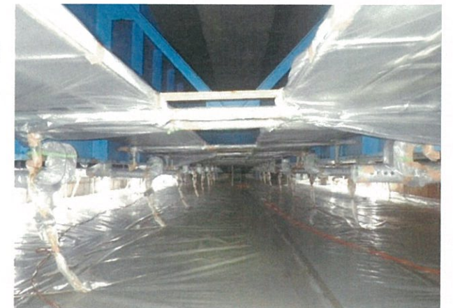
床全面シート張り(参考写真)
